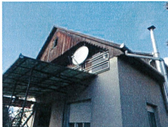
12. lakóház udvari homlokzata
