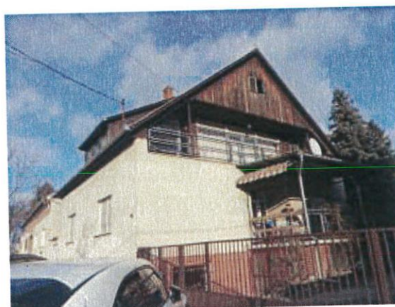
04. épület utcai homlokzata
