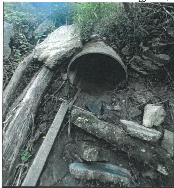
2.szakasz: Betontörmelékkel, beton gyűrűvel eltorlaszolódott mederszakasz
