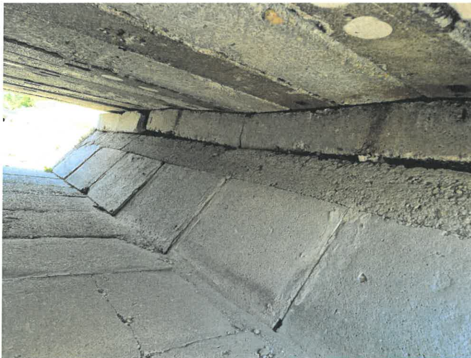
21. kép – Ág utca (717/3 hrsz.) 10. sz előtti kapubehajtó alatti burkolt árok átvezetése, eltört tartógerendák
