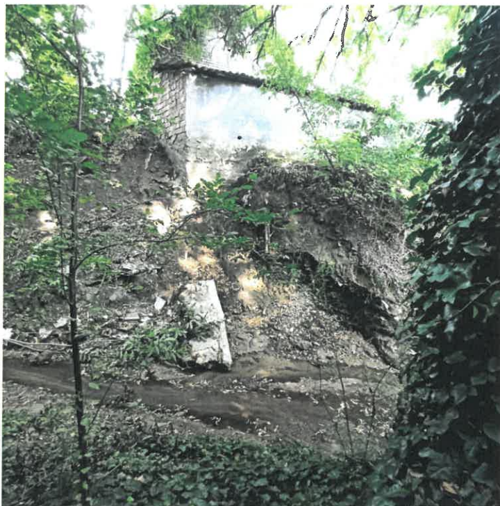
5. kép – Karéjos kimosódás a patak balpartján (1456 hrsz.), melléképület alámosódása
