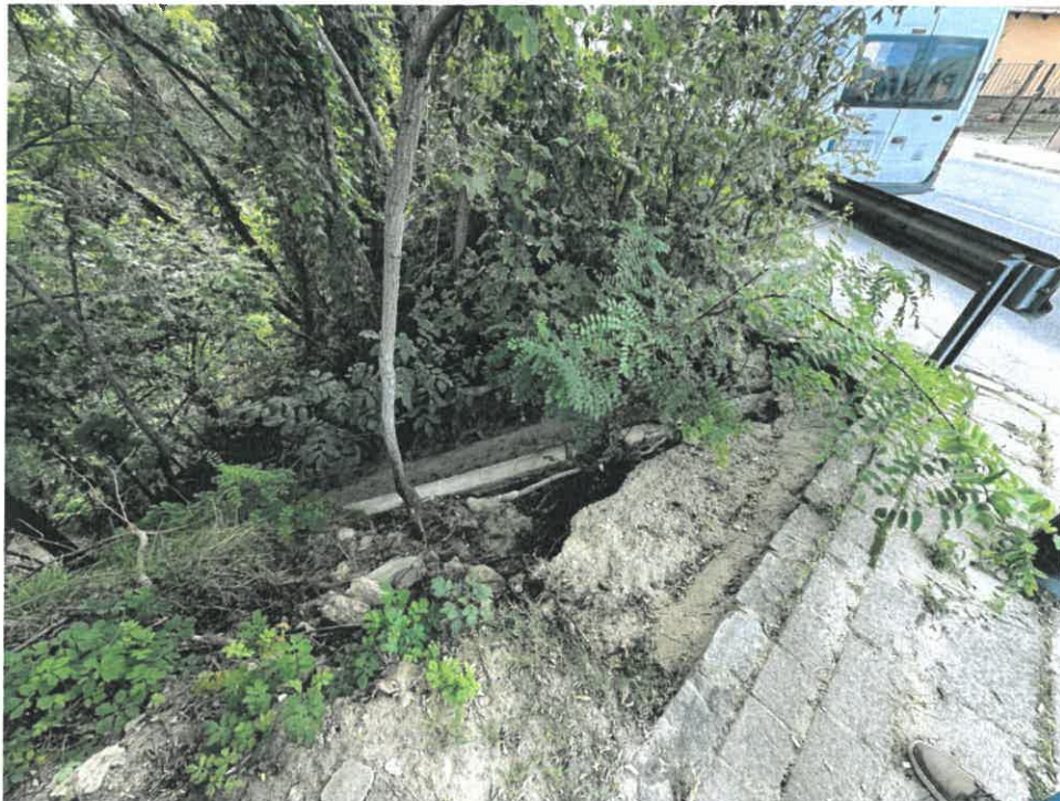
2. kép – Fóti út (1456 hrsz.) a surrantó alatti kimosódás a patak jobbpartján
