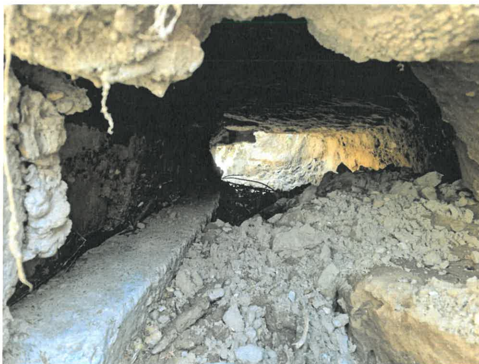
21. kép – Ág utca (717/3 hrsz.) 10. sz előtti kapubehajtó alatti burkolt árok átvezetése, eltört tartógerendák
