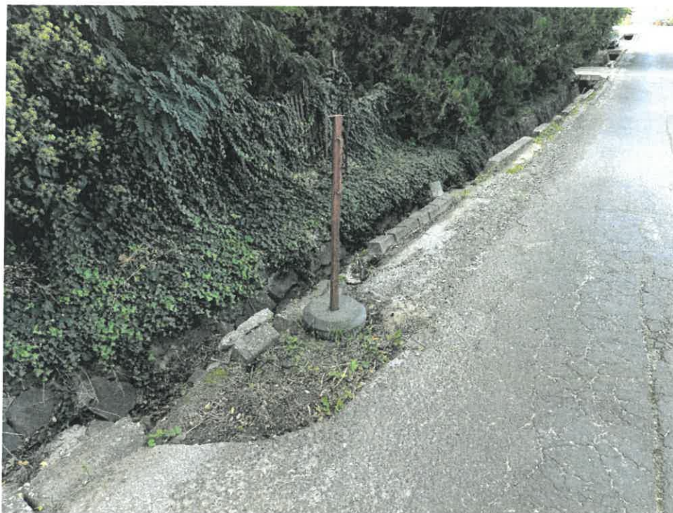
19. kép – Kiss Ernő utca (314/1 hrsz.) árok- és útburkolat károsodása
