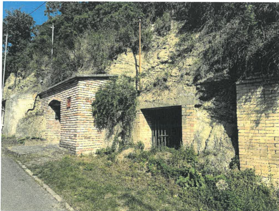
11. kép – Pincesor utca (231/1; 231/2 hrsz.) partfal károsodás
