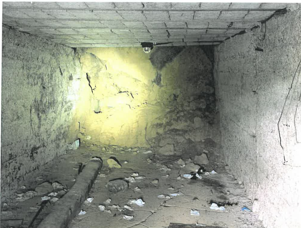
9. kép – Rózsa utca 2-4. sz. (1114 hrsz.) alatti tárolóhelyiség – pince beomlás a vájvégen
