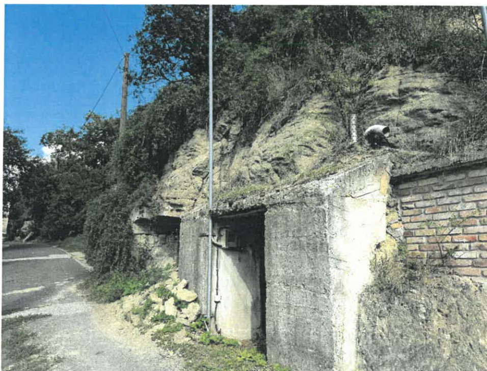
11. kép – Pincesor utca (231/1; 231/2 hrsz.) partfal károsodás
