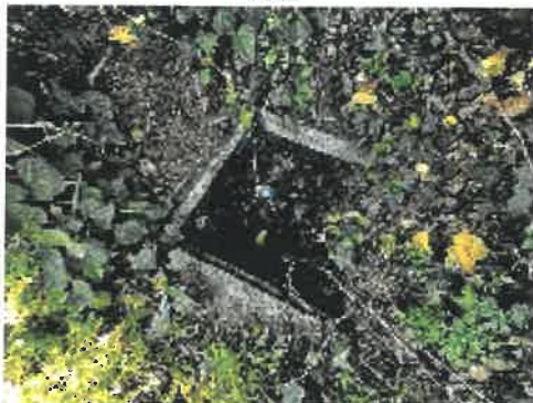
Feltehetően korábbi közműóra számára fenntartott akna.
