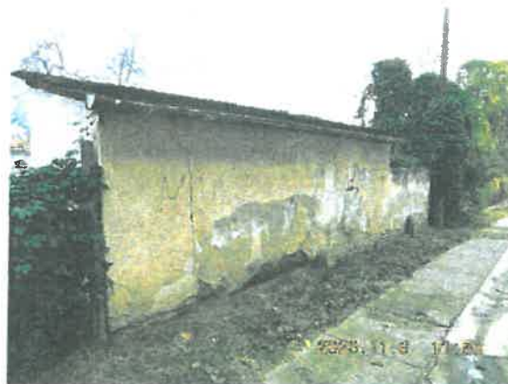
A kültéri WC Mérleg úti homlokzata
