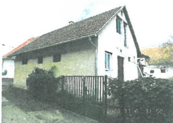
A vendéglátóipari épület Mérleg úti épületszánya
