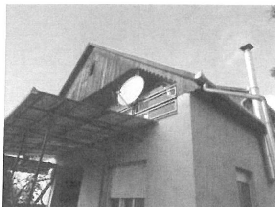
12. lakóház udvari homlokzata
