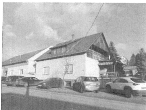
03. épület utcai homlokzata
