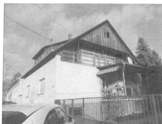
04. épület utcai homlokzata
