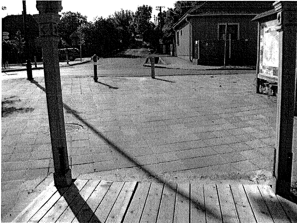
5.kép: A Kiss Ernő utca ( szemben) árkából és az útról a balparti gyalogos híd hídfőjére egyenesen zúdult rá a víz, mely a hídnál ömlött be koncentráltan a mederbe. Emiatt vannak intenzív károk a hídfőknél, mindkét oldalon (a balparton intenzívebb)
